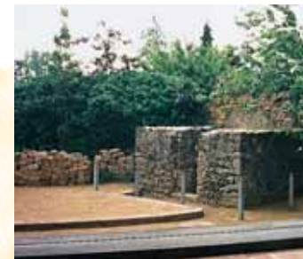
GROSSKROTZENBURG TORRE D'ANGOLO DEL CASTRUM
